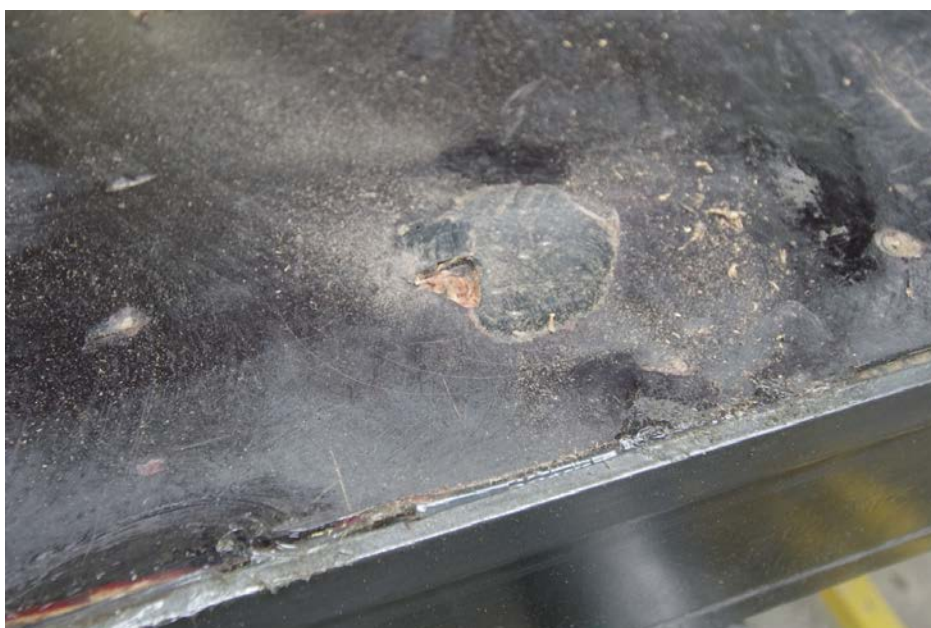
wyfrezowane miejsce do zalania (obok widać stare naprawione uszkodzenie, zalane klejem) – fot. BizeA
