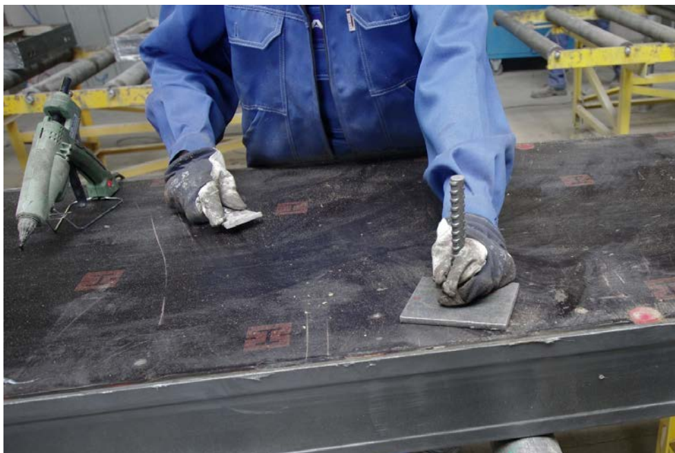
W drugim ręku widać strug do zdjęcia nadmiaru kleju po schłodzeniu
